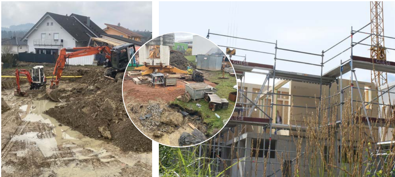
Ein paar Eindrücke unserer Baustelle
